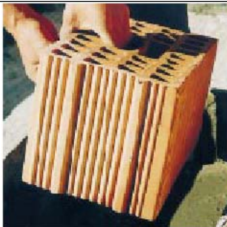
Укладка блока на ADESILEX P4
