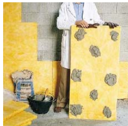
точечное приклеивание изоляционных материалов
