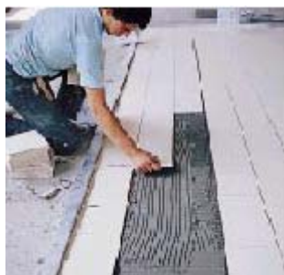
Укладка фарфоровой неглазурованной плитки на производстве
