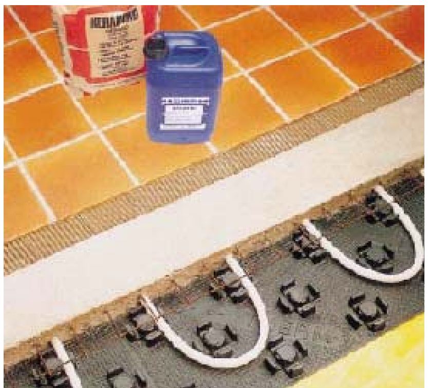
Укладка плитки на систему обогрева пола
