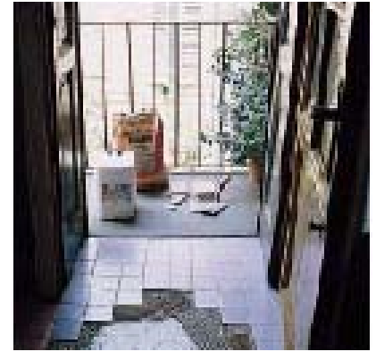
Укладка плитки на старую плитку
