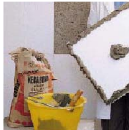
Точечное приклеивание пенополистирола
