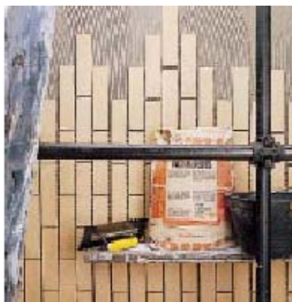
Укладка наружной настенной плитки
