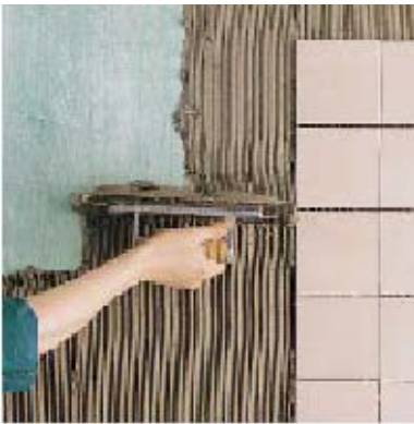
Укладка плитки на гипсовую стену обработанную PRIMER G
