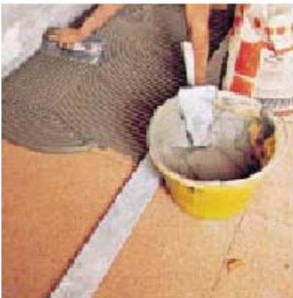
Укладка плитки на пробковый слой в здании из сборного железобетона
