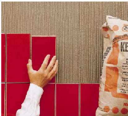
Укладка настенной плитки
