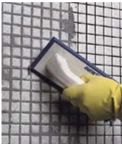
Заполнение швов стеклянной мозаики шпателем
