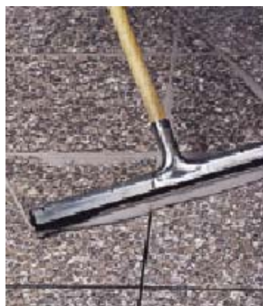
Заполнение швов гранитной облицовки перед полировкой
