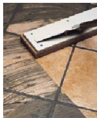
Окончательная очистка напольной облицовки губкой
