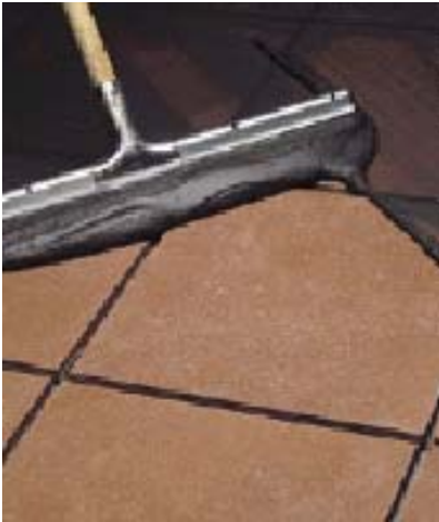
Расшивка швов терракотовой облицовки с помощью резинового скребка
