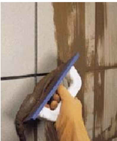
Расшивка швов наружной настенной облицовки с помощью мягкого шпателя
