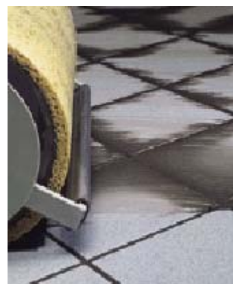
Окончательная очистка машиной
