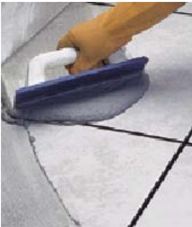
Расшивка швов керамической облицовки с помощью мягкого шпателя
