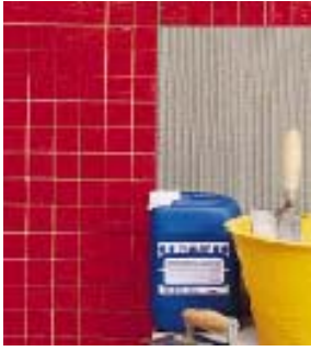
Облицовка стеклянной мозаикой
