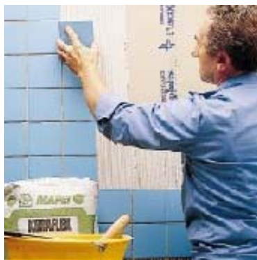
укладка плитки на гипсокартон с помощью KERAFLEX
