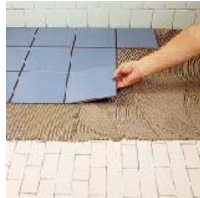
облицовка плиткой поверх существующего керамического покрытия с помощью клея KERAFLEX
