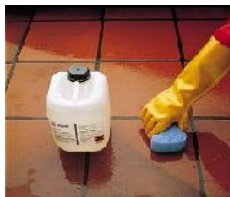
очистка жидким составом
