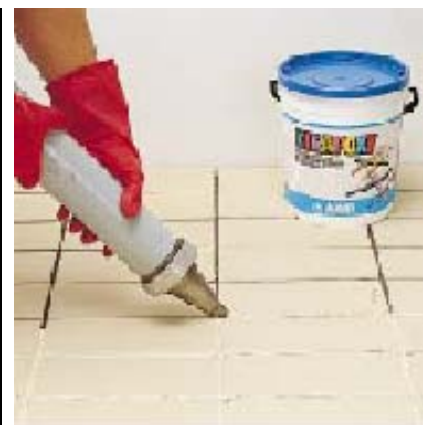
Нанесение с помощью ручного пистолета
