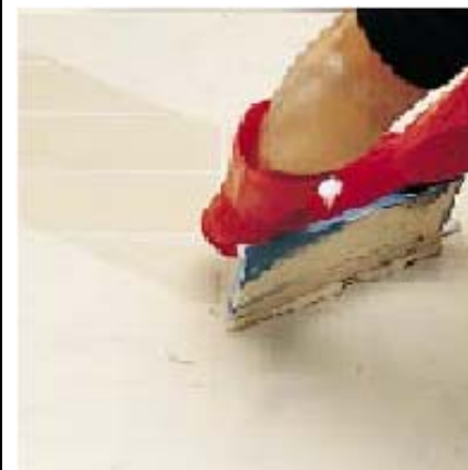
Удаление избыточного материала с помощью резинового мастерка
