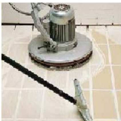
Очистка с помощью затирочной машины
