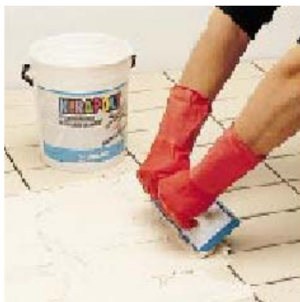
Нанесение с помощью резинового мастерка
