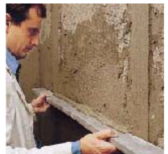
Выравнивание слоя NIVOPLAN рейкой
