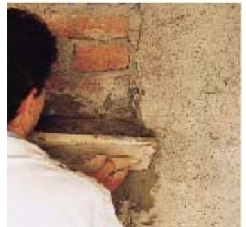
Реставрация NIVOPLAN -ом старой кирпичной стены
