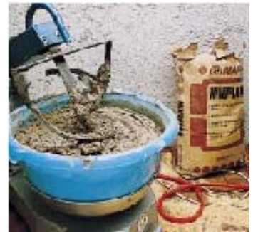
Замешивание NIVOPLAN -а на мини-миксере
