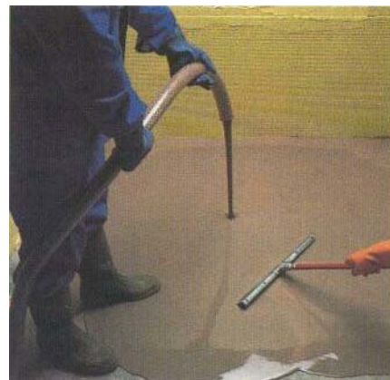
4 - Нанесение ULTRAPLAN насосом и резиновым скребком
