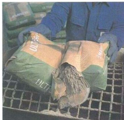
Замешивание ULTRAPLAN дозирочной установкой
