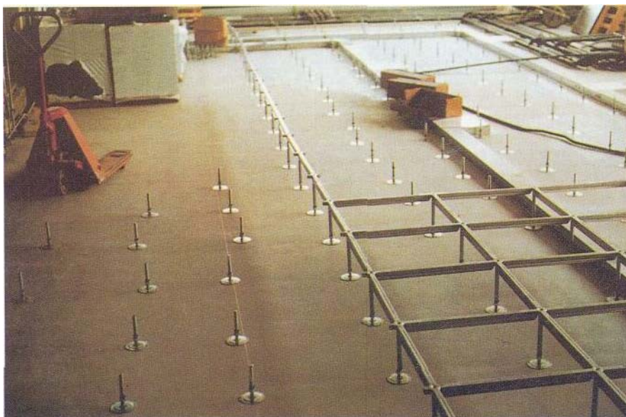
Основание, выровненное ULTRAPLAN , готово к устройству «плавающего» пола
