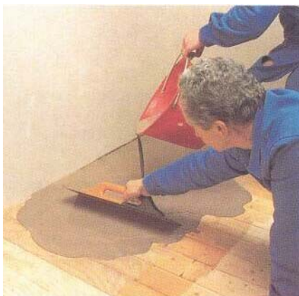
3 - Нанесение ULTRAPLAN
